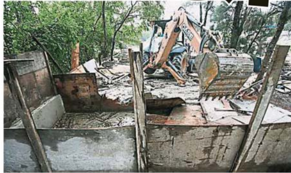
梳邦再也市议会出动神手，拆除非法建筑物架构。
